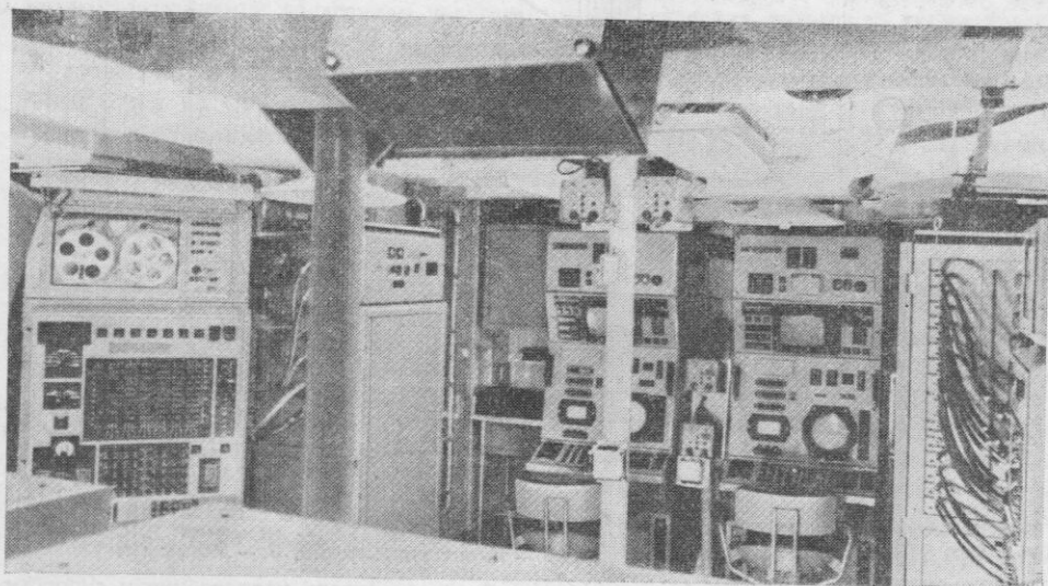
Рис. 4. ЭВМ и два пульта управления артиллерийским комплексом «Дардо» Фото из журнала «Армада интернэшнл»
